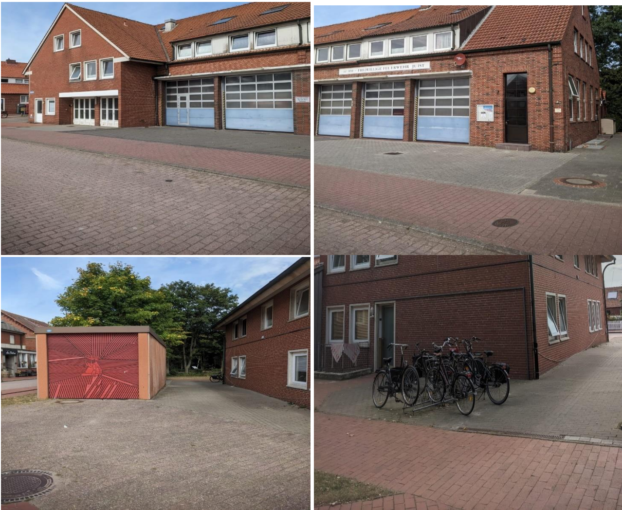
Fotos vom ehemaligen Feuerwehrgebäude
