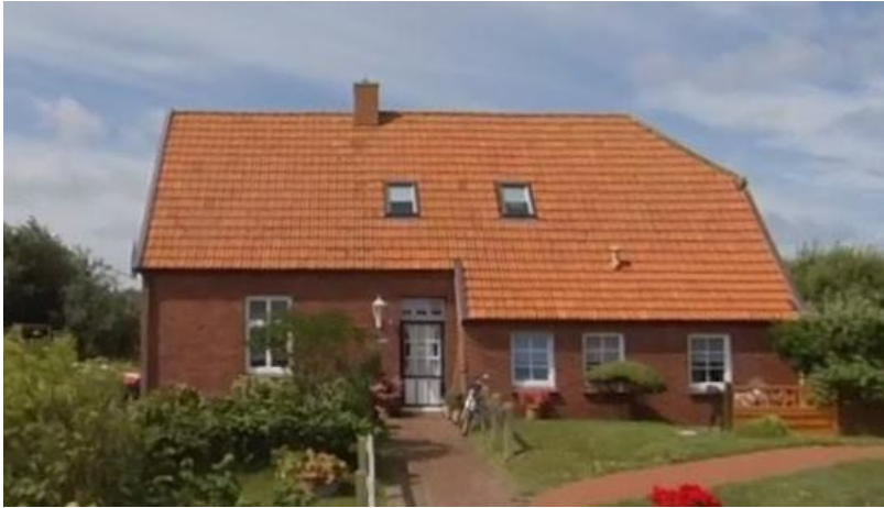
Abbildung 20: ehemaliger Wirtschaftsteil – rechte Gebäudeseite
