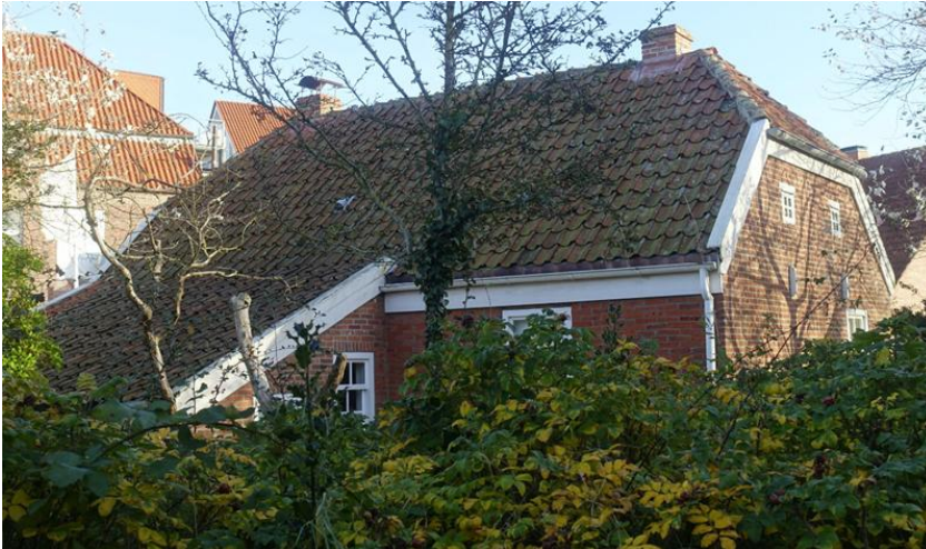
Abbildung 28: Eingeschossiges Backsteingebäude unter ziegelgedecktem Krüppelwalmdach, mit Anbau
