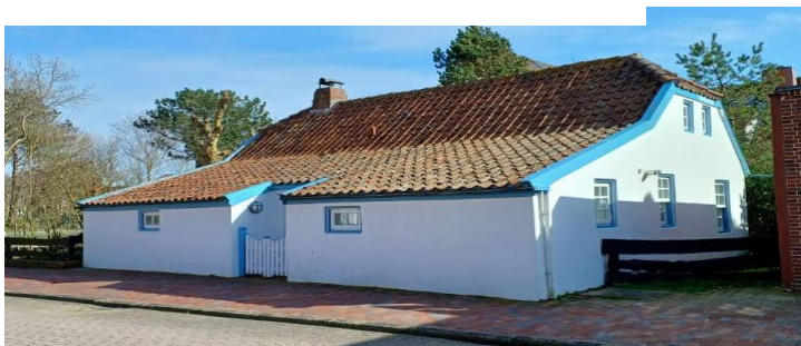
Abbildung 54: Krüppelwalm mit Dachabschleppung
