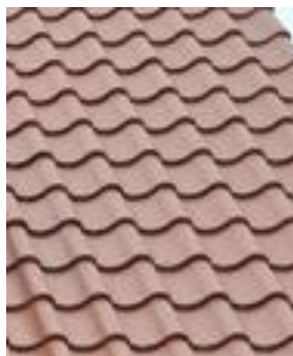
Abbildung 161: Holzfalzziegel
