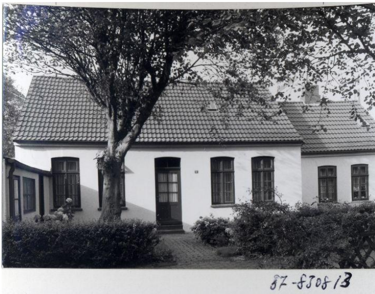
Abbildung 126: Wohnhaus mit Putzfassade, flachgeneigtes Dach mit einem angebauten Stallteil
