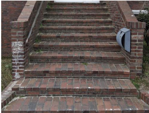
Abbildung 168: Eingangstreppe aus Ziegelsteinen
