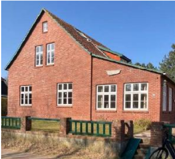
Abbildung 82: Wohnhaus mit massivem Anbau im Verandastil
