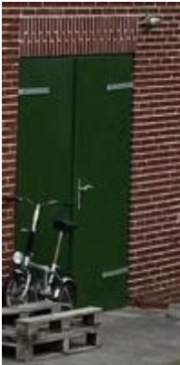
Abbildung 22: Tür / Tor im Nebengebäude
