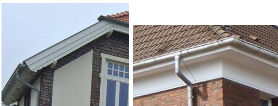
Abbildung 153: Ausbildung der Dachüberstände an der Traufe
