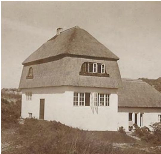
Abbildung 31: Die ehemalige Weberei
