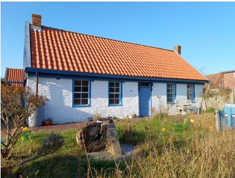
Abbildung 26: Wohnhaus von 1836 nördlich des Loogster Pads mit alten
