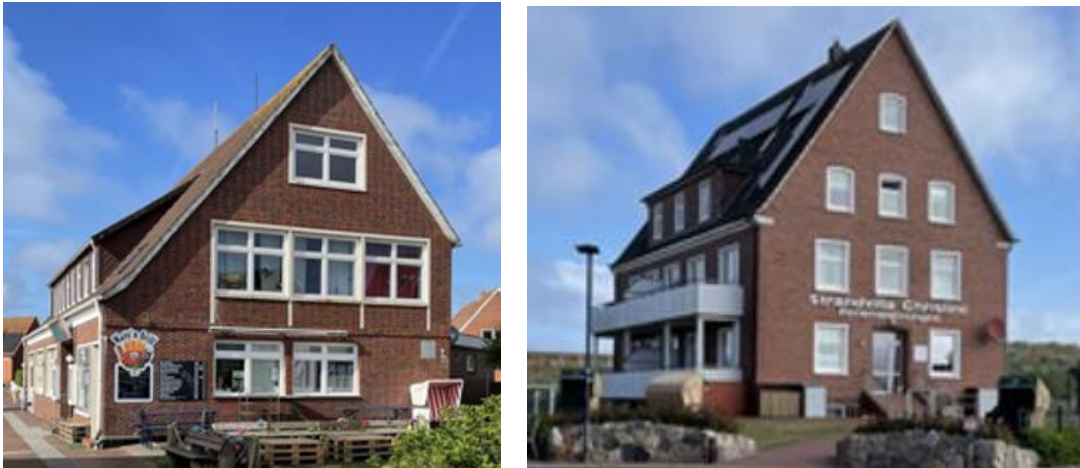
Abbildung 9: Wohn- und Geschäftshäuser im Inselzentrum
