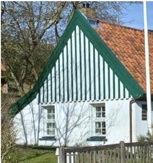
Abbildung 47: Verputzter Backsteinbau mit senkrechten Holzverschalungen im Giebel und Hebefenster
