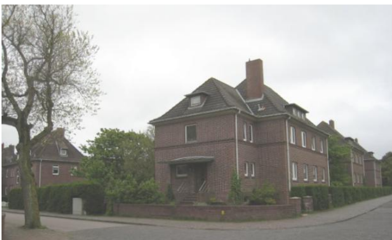
Abbildung 133: Zweigeschossiger Ziegelbau mit Walmdach und Schleppgauben Charlottenstraße / Rösingstraße
