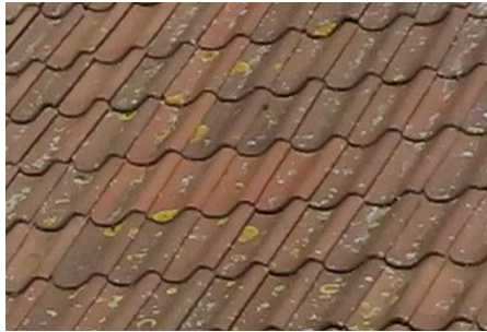
Abbildung 108: Hohlfalzziegel
