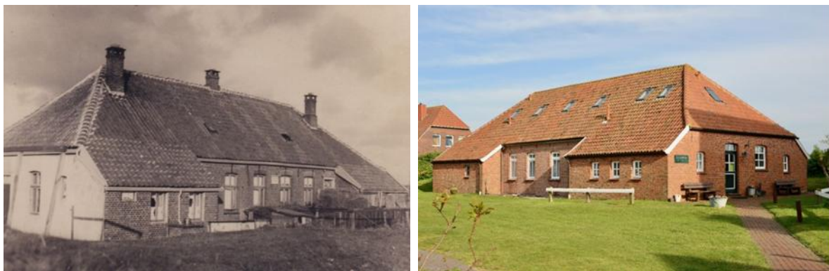
Abbildung 3: Zollhaus erbaut um 1855 als ostfriesisches Doppelwohnhaus für zwei Zollfamilien
