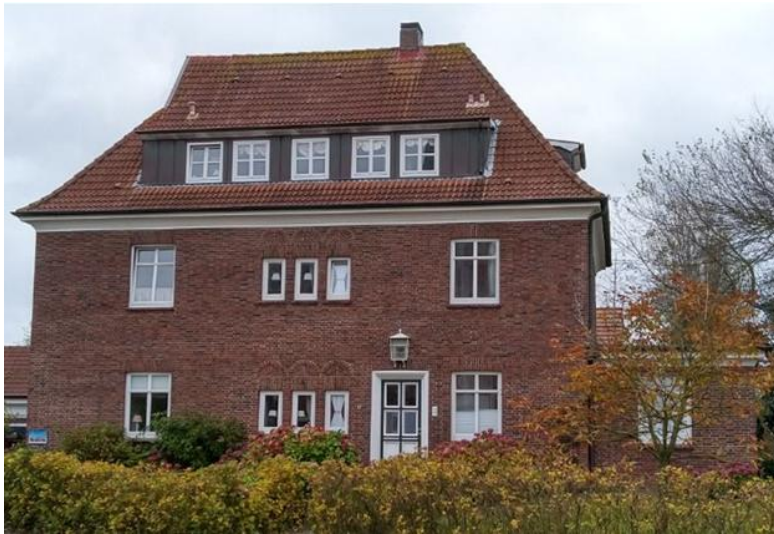
Abbildung 35: "Haus van Lessen" wurde als Arztvilla um 1930 erbaut
