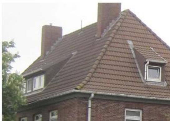
Abbildung 150: Walmdach mit Schleppegaben
