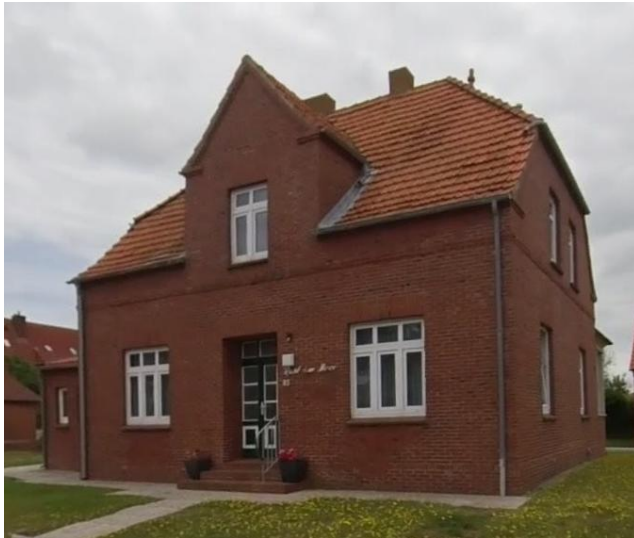
Abbildung 16: Wohngebäude mit Zwerchhaus
