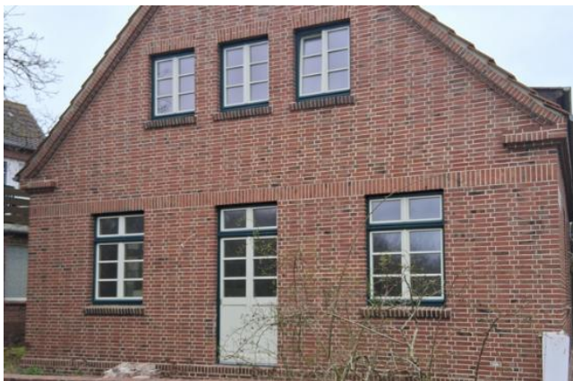
Abbildung 144: Gebäude mit Ziegelmauerwerk
