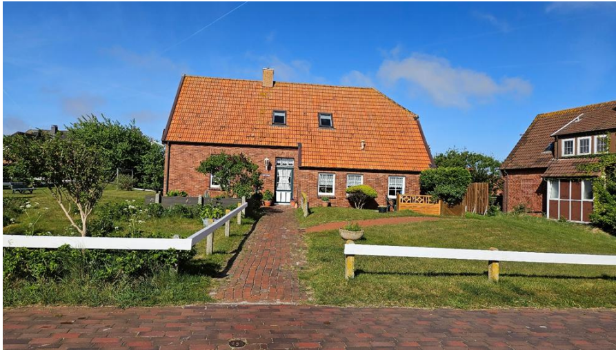
Abbildung 4: Ehemalige Wohn- und Wirtschaftsgebäude
