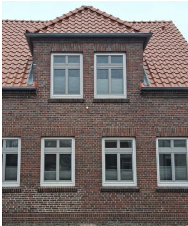
Abbildung 156: Zwerchhaus mit Walmdach
