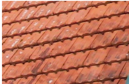
Abbildung 109: Doppelmuldenziegel
