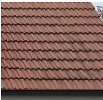
Abbildung 160: Doppelmuldenziegel
