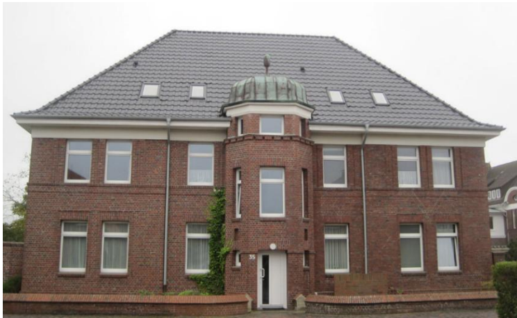
Abbildung 134: Ehemalige Kasernenanlage – polygonales Treppenhaus
