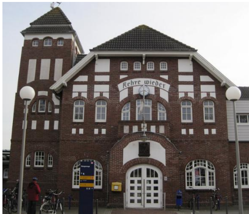
Abbildung 145: Putzelemente in Klinkerfassade
