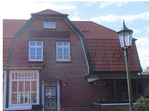
Abbildung 102: Mansarddach mit Zwerggiebel
